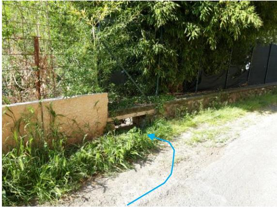
*Fenditura del muro di recinzione presente lungo la via Saga che consente l'ingresso delle acque meteoriche di dilavamento della sede stradale nel fosso del reticolo idrografico del torrente Gazza.*
