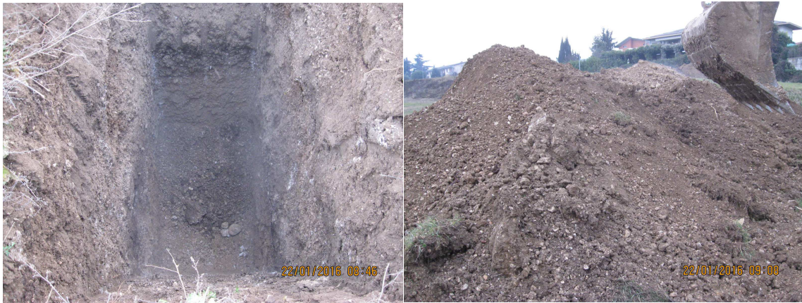
Fig. 5: lo scavo n. 1 (2016) e il materiale di risulta. Si noti la ghiaia al fondo
