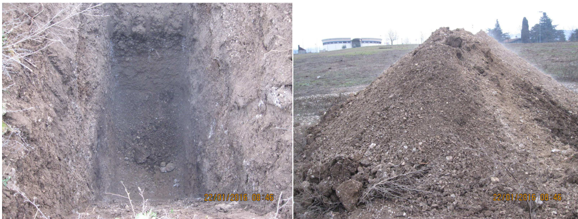
Fig. 6: lo scavo n. 1 (2016) e il materiale di risulta. Si noti la ghiaia al fondo
