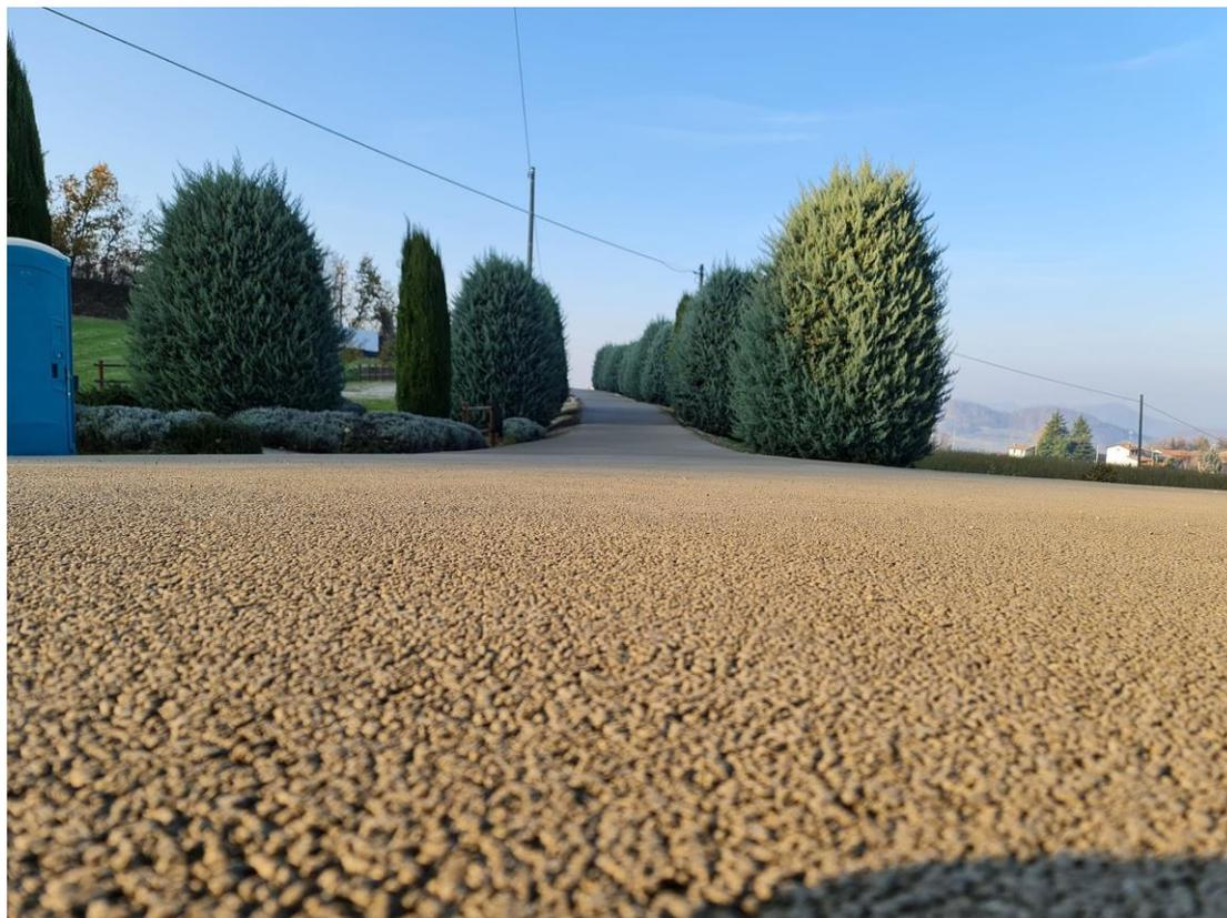
Figura 13 esempio di substrato drenante per parcheggi (<https://ecodrainsrl.com/>)
